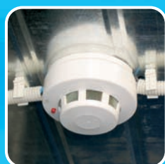
Датчик системы пожарной сигнализации
